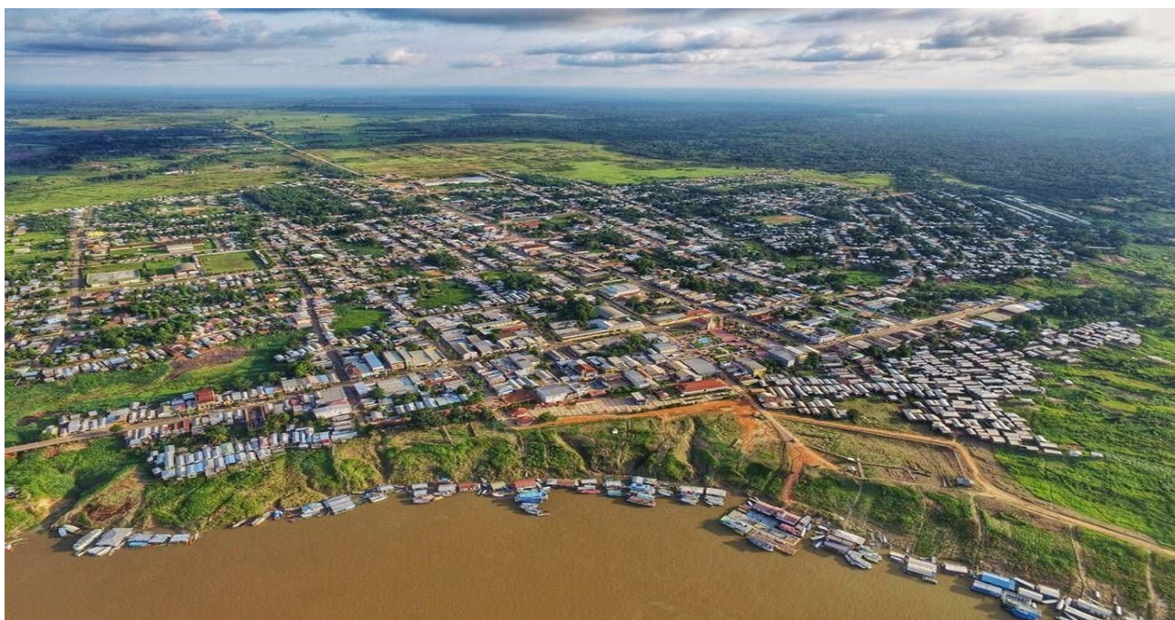
Figura 1. Município de Lábrea-AM. Fonte: Google imagens.
