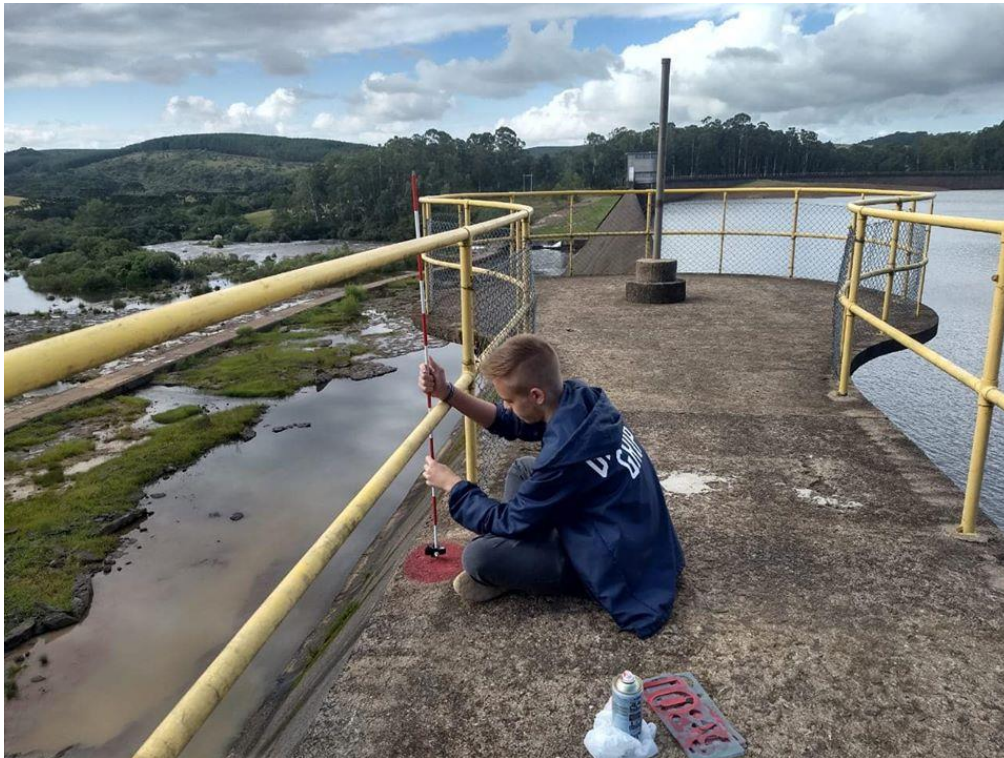
Figura 3. Detalhe do alvo topográfico instalado e o mini-prisma.
