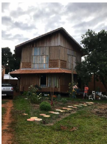
Figura 1. Vista frontal da edificação.
