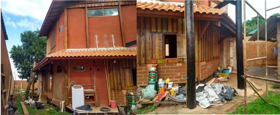
Figura 2. Vistas laterais da edificação.
