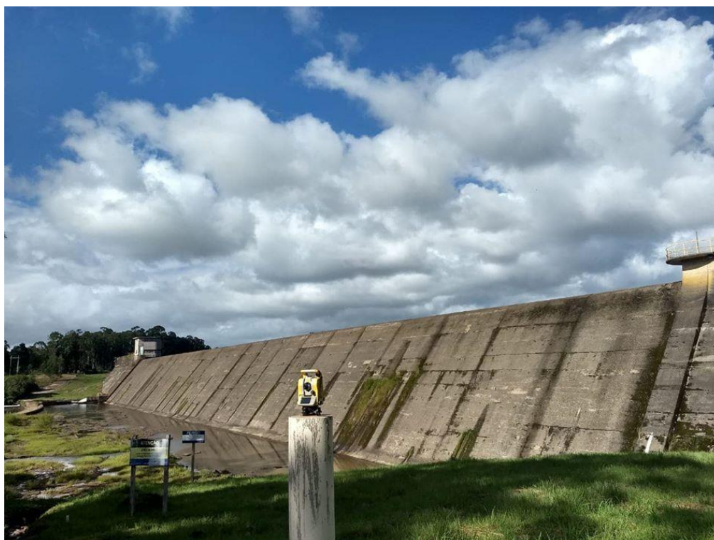
Figura 2. Visualização do pilar de concreto armado com dispositivo de centragem forçada onde é instalado o equipamento topográfico.
