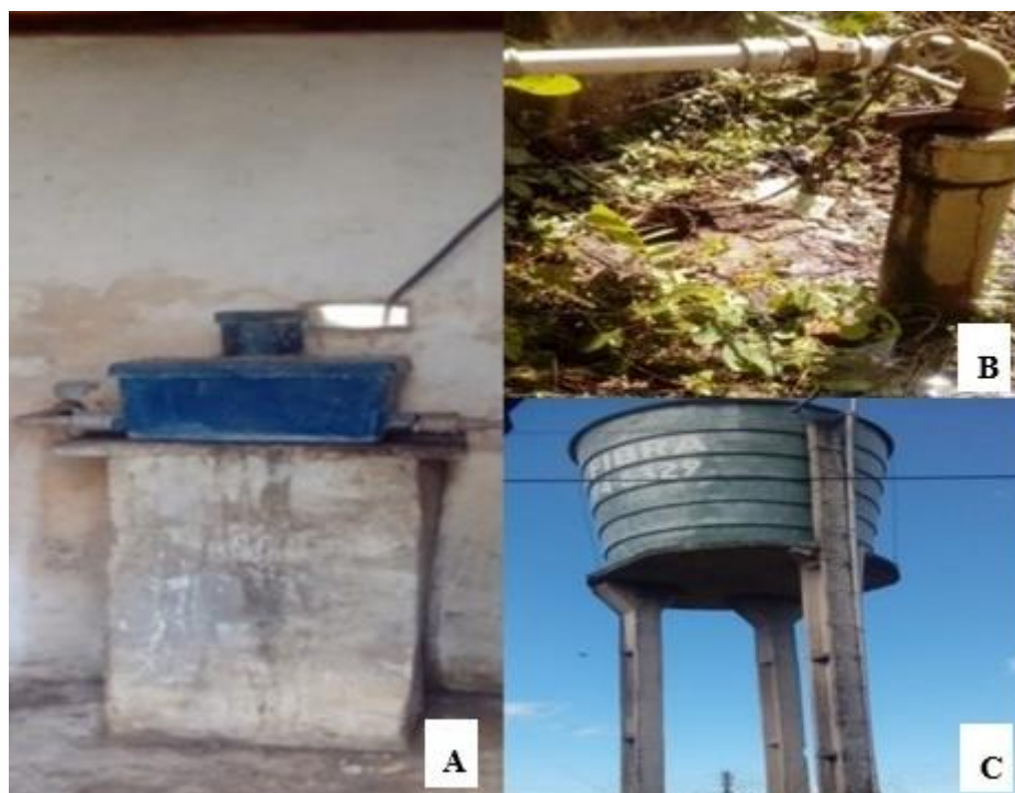
Figura 8. Sistema de abastecimento de água do Povoado Alegria.
