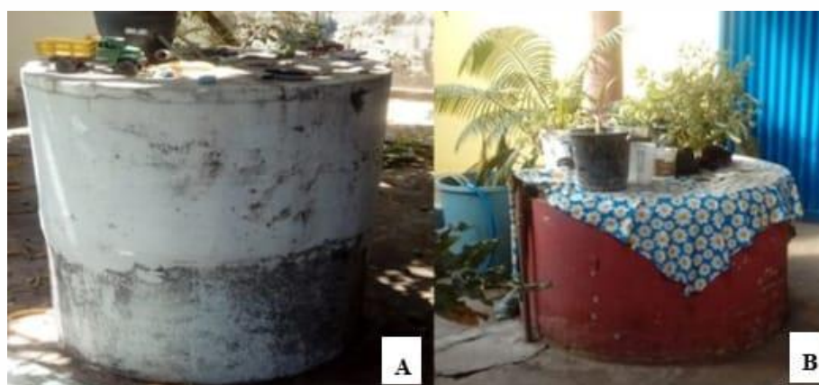
Figura 6. Fotografias dos poços cacimbões vedados com concreto armado.
