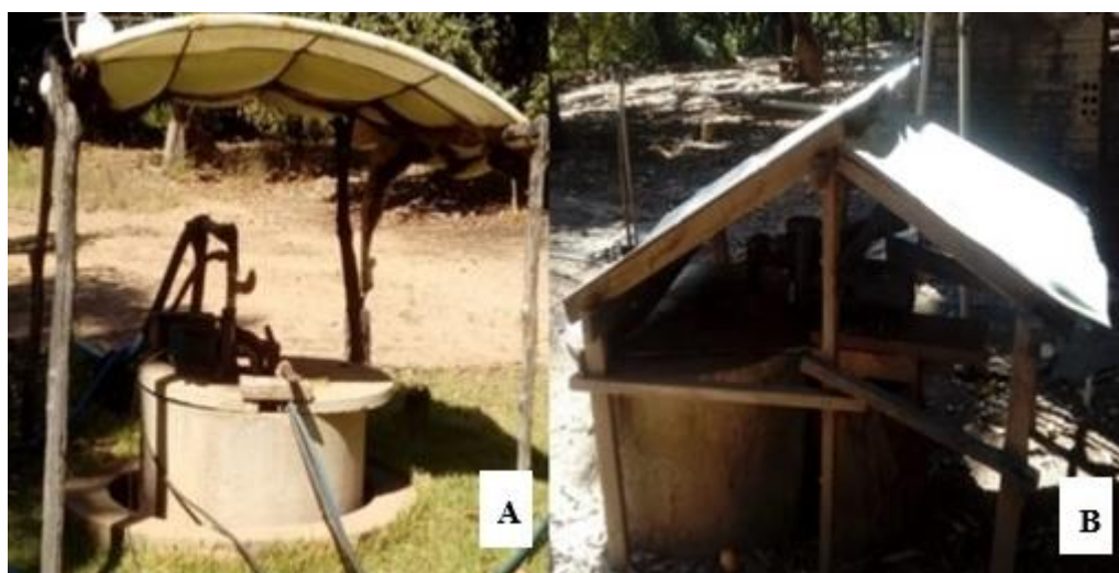
Figura 7. Poços cacimbões com casas de proteção.
