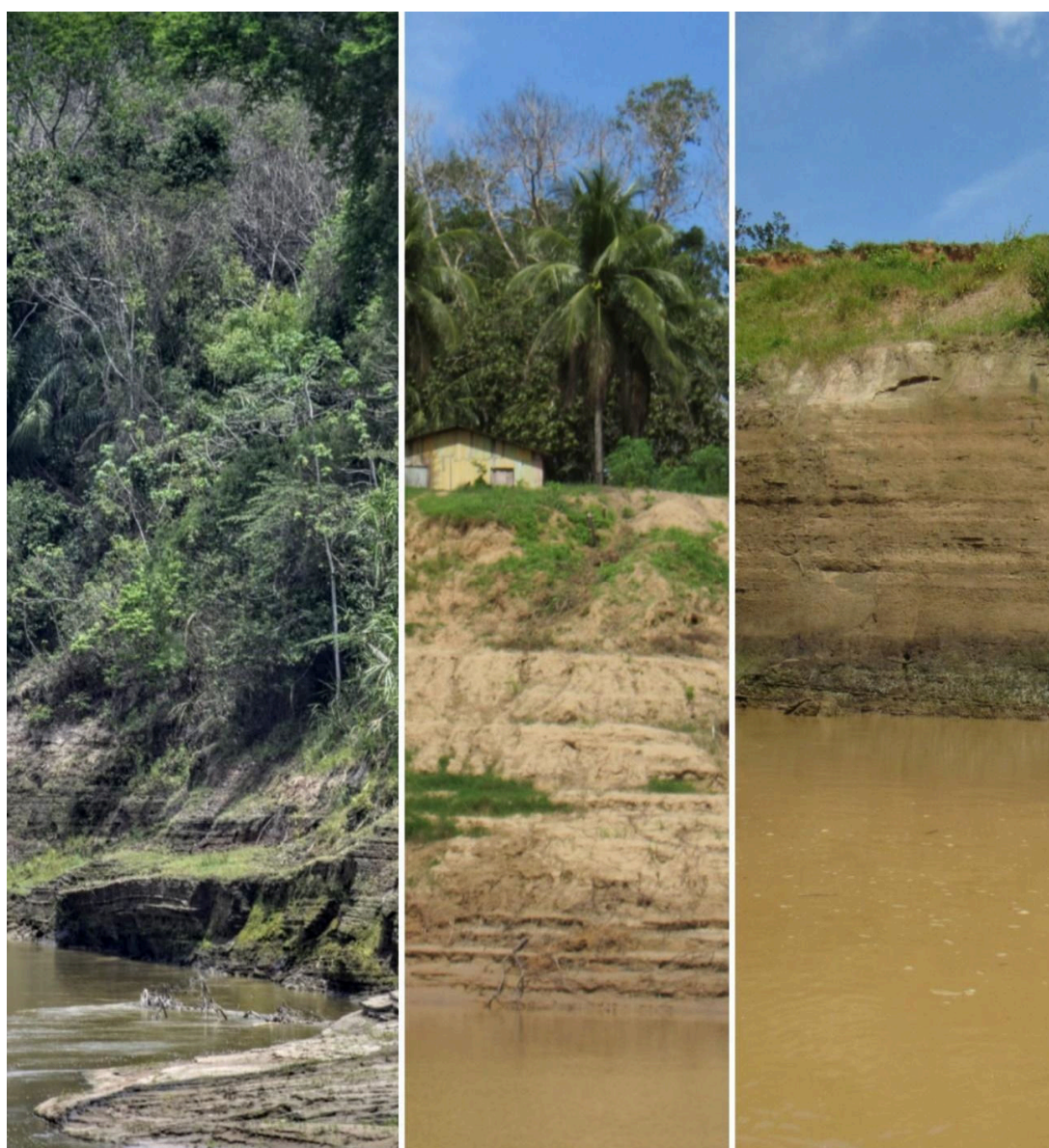
Figura 7. Salões associados às margens altas do rio Acre, na APA Lago do Amapá, Rio Branco, Acre, e com distintos tipos de cobertura. Ponto de observação 19, da esquerda para a direita, salão com floresta madura, salão em área desmatada com moradia e salão em área com pastagem.
