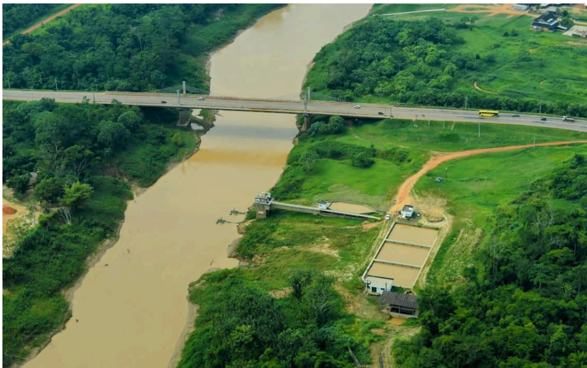
Figura 1. Terceira ponte sobre o rio Acre, parte dos 13 km da Via Verde e em primeiro plano, a Estação de Tratamento de Água. Rio Branco, Acre.
