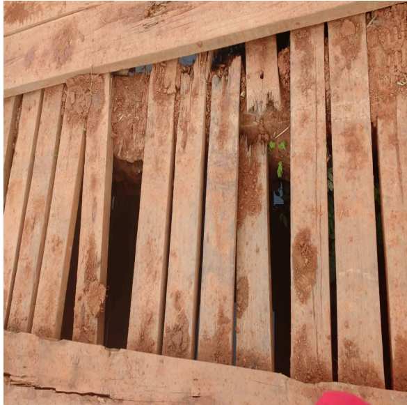
Figura 20. Ponte que dá acesso ao PA Espinhara II (NASCIMENTO, 2018).
