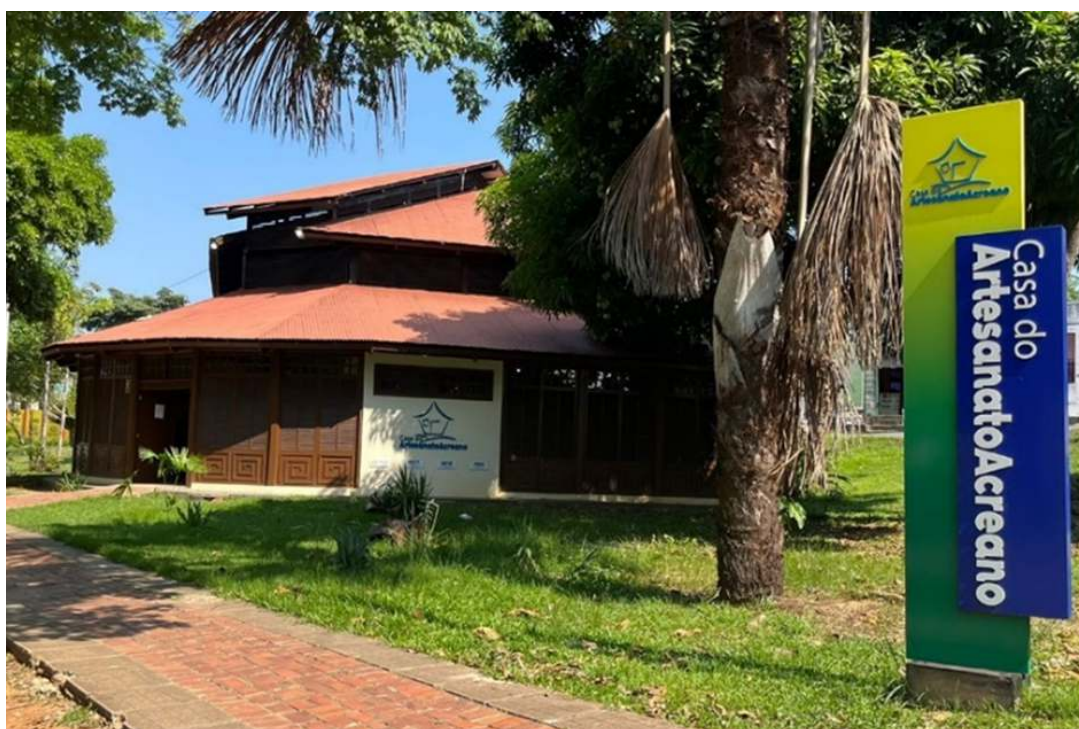
Figura 8. Calçada em estado satisfatório, edificação e totem em boas condições.
