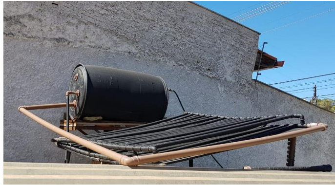
Figura 9. Visualização da instalação finalizada.
