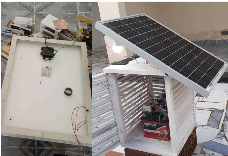
Figura 9. montagem e execução do projeto
