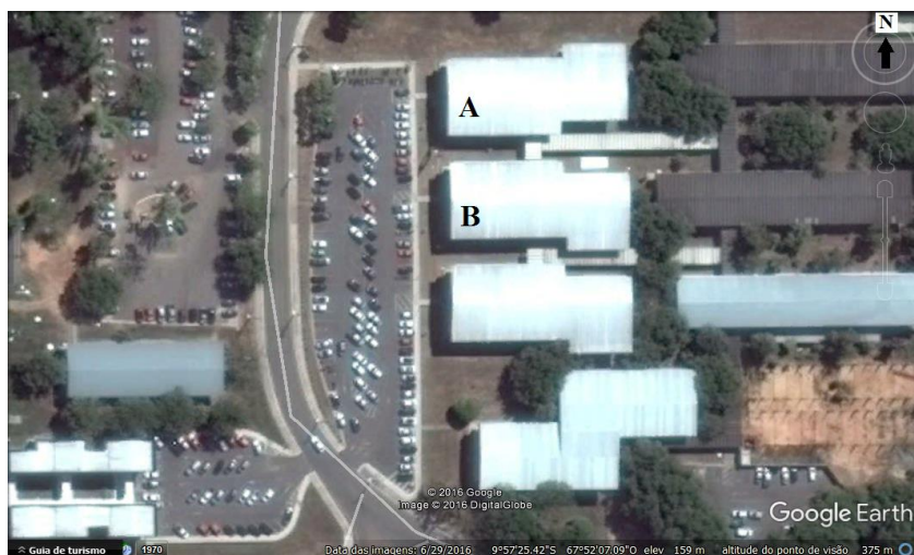
Figura 2. Vista superior do Bloco Omar Sabino. Fonte: Adaptado de Google Earth (2016).
