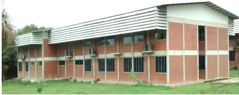
Figura 1. Vista lateral e frontal do Bloco Omar Sabino.
