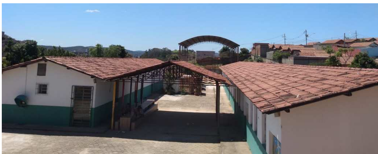
Figura 3. Telhado da escola.
