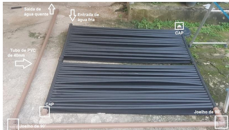
Figura 5. Conexão da placa de PVC com os tubos de PVC
